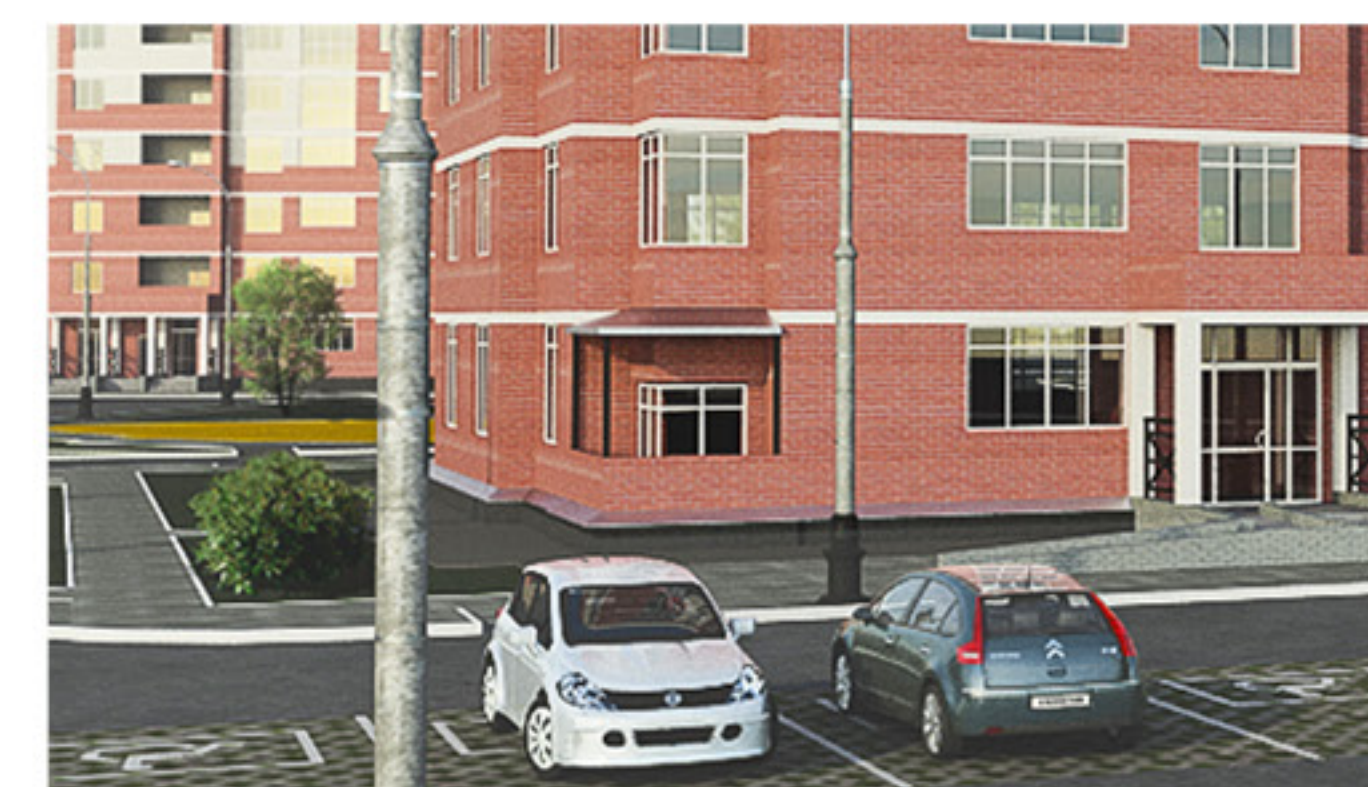
Наличие наземной парковки по периметру
